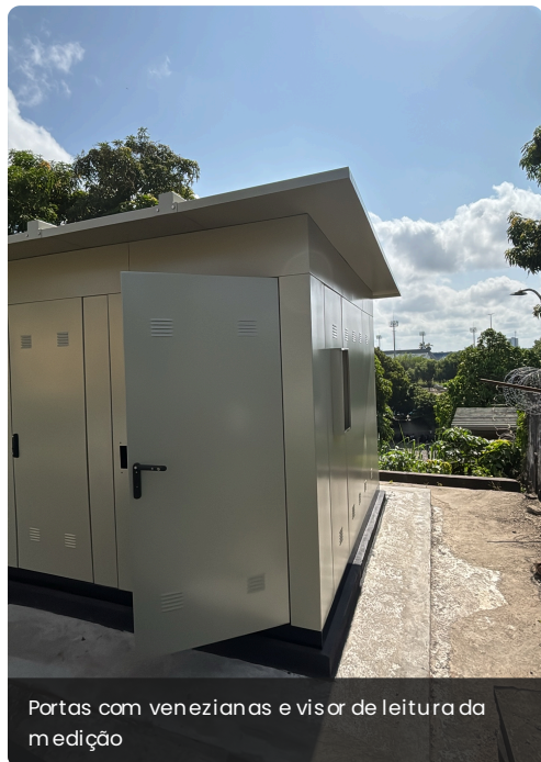
Compartimento do transformador
